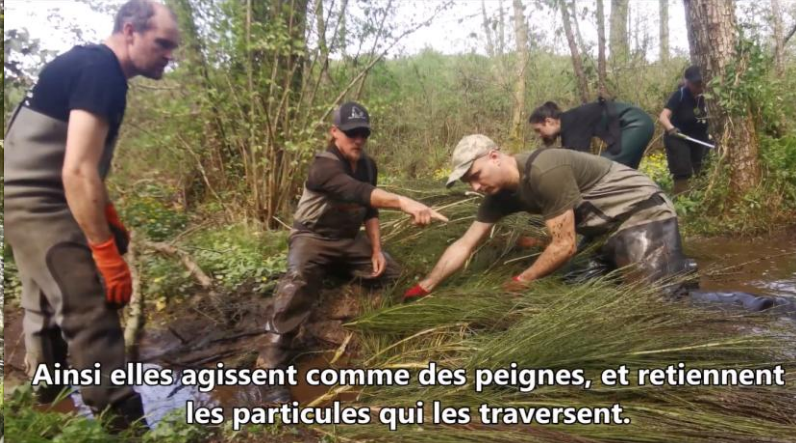
Pour consolider le barrage, on alterne les branches avec des couches de sédiment provenant de la rivière.
