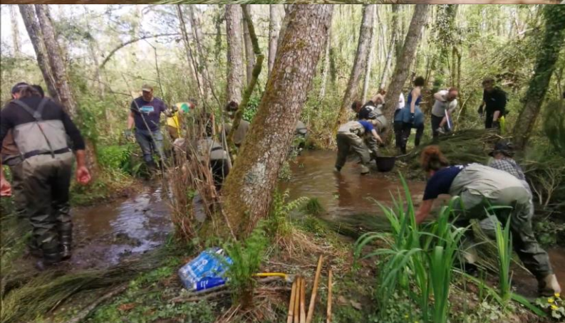
Pour consolider le barrage, on alterne les branches avec des couches de sédiment provenant de la rivière.
